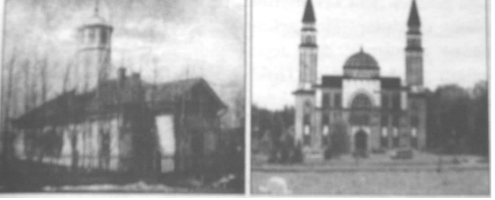
Bu küçük caminin Üstad'ın kaldığı zamanki ve şimdi inşaat halindeki hali.
